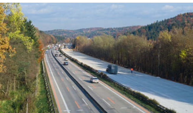
Seit Juni 2007 werden auf der A2 Südautobahn, Gleisdorf West-Lassnitzhöhe (Steiermark), Straßen- und Brückeninstandsetzungsarbeiten durchgeführt. Dies umfasst u. a. die Randbalkensanierung, Tragwerksneuerstellung sowie die Hangsicherung.
