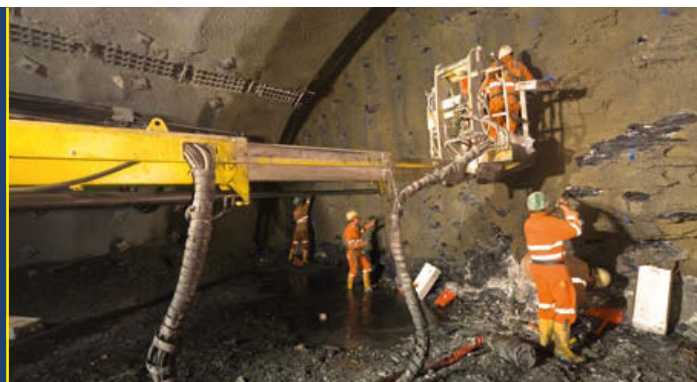
Seit Juli 2006 wird auf der A10 Tauernautobahn die 2. Röhre des Tauern隧unnels errichtet. Mit einer Gesamtauftragssumme von 109 Mio. EUR soll dieses Projekt bis Mai 2010 fertiggestellt werden.
