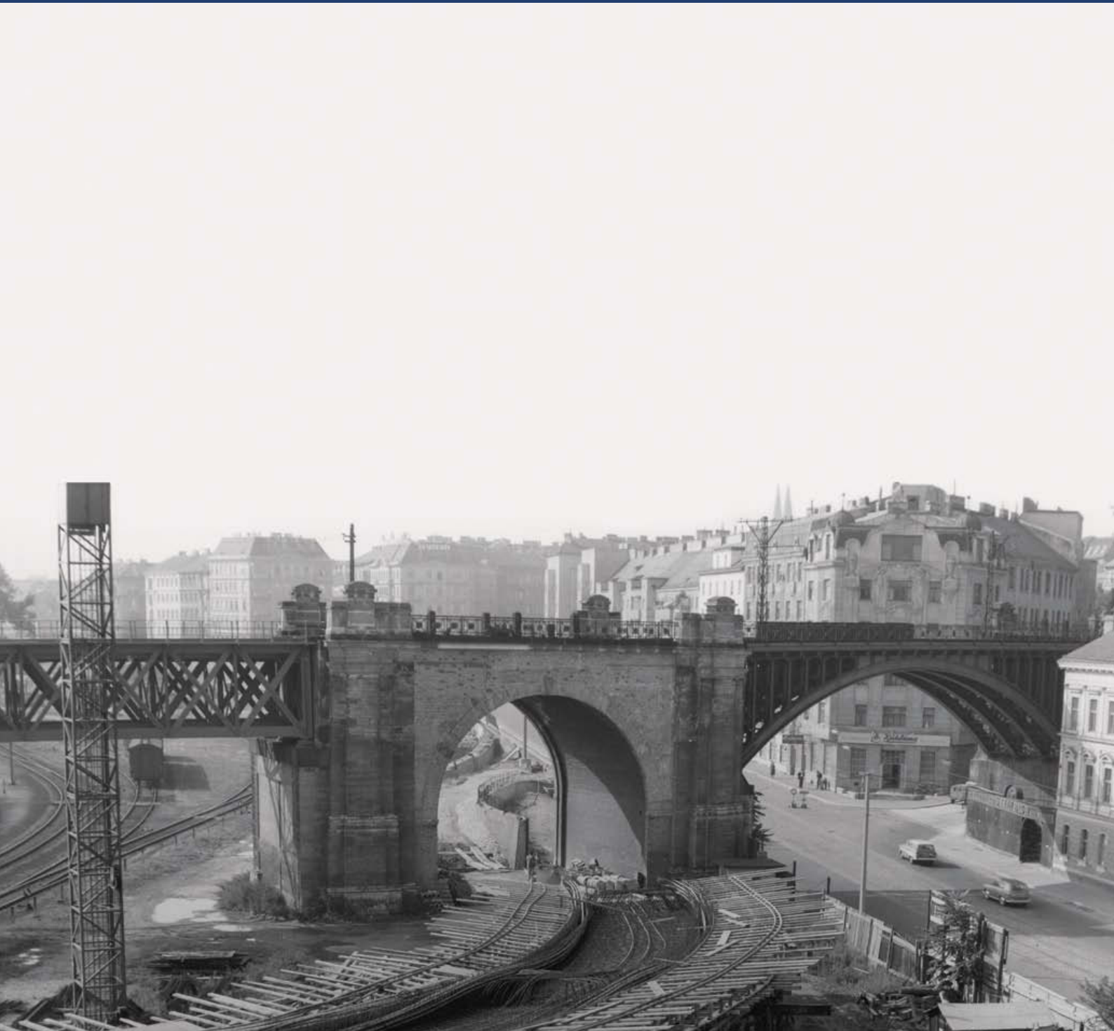
Stadtbahnbrücke, 19. Wiener Gemeindebezirk
