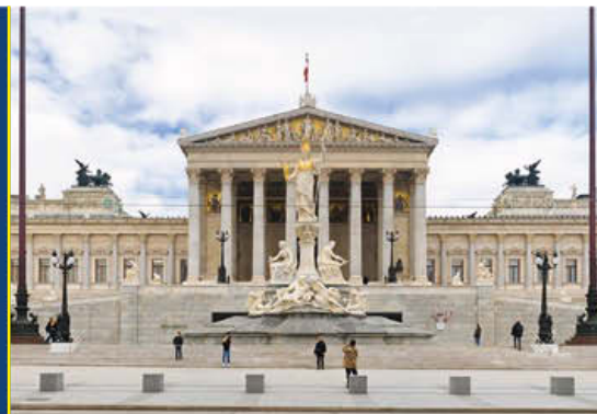
Im Zuge der Rampen- und Brunnensanierung des Parlamentsgebäudes in Wien wurden die Rampen- und Stufenanlage abgetragen und vollständig neu aufgebaut sowie Steinrestauratorenarbeiten durchgeführt.
