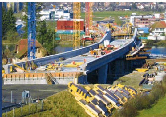
Die Aarebrücke/Solothurn in der Schweiz mit einer Gesamtlänge von 387,36 m ist als Durchlaufträger mit schwimmender Lagerung konzipiert. Sie wird 2008 fertiggestellt.
