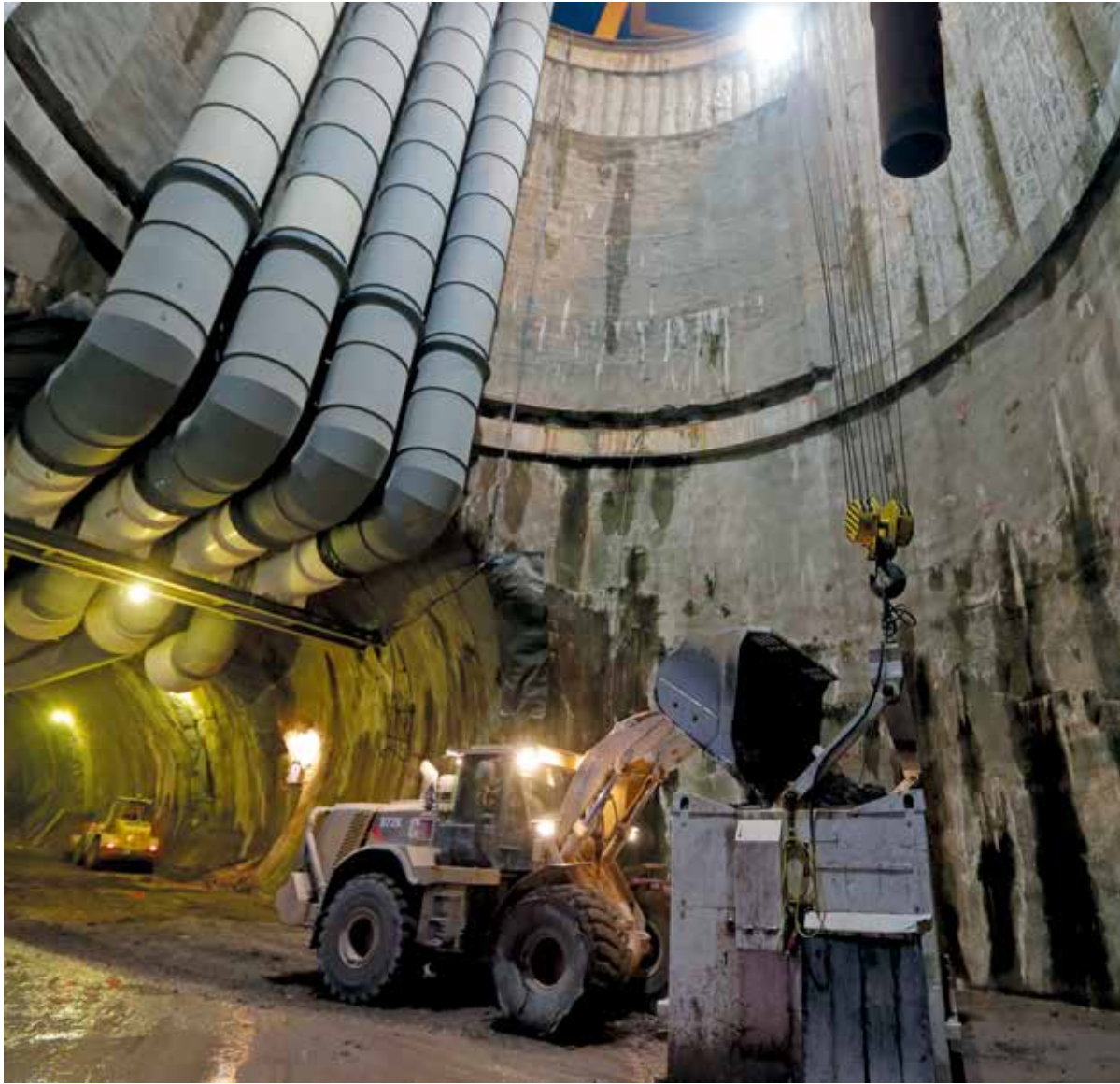
Stuttgart 21 . Baulos Ober- und Untertürkheim Über den Schacht Ulmerstraße wird die Ver- und Entsorgung von vier Vortrieben realisiert
